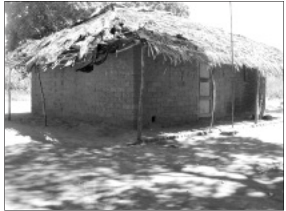
Figura 1 - Tipica abitazione di Marrere costruita con mattoni di sabbia e acqua e tetto in paglia.
